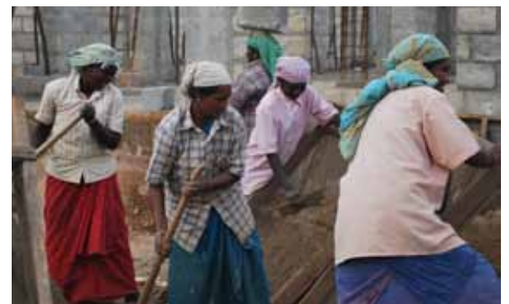
Zowel dames als heren zijn bij de bouw betrokken.
